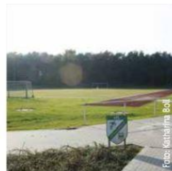
Zwischen April und August 2014 wurde der Kunstrasenplatz errichtet.
