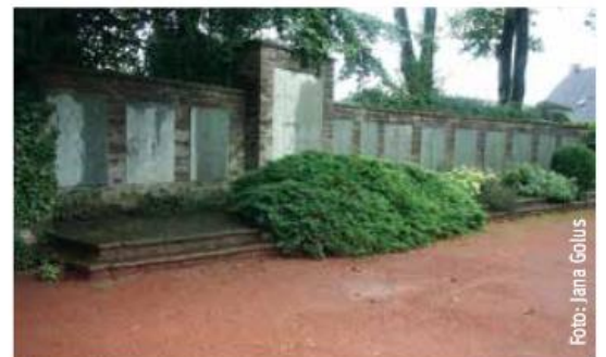
Das stark beschädigte Kriegerdenkmal wurde abgerissen und durch das neue Ehrenmal, das heute noch steht, ersetzt.
