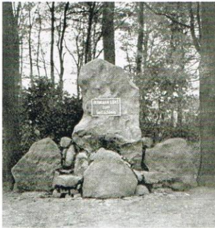
1929 wurde das Hermann-Löns-Denkmal am Schwarzbach errichtet.
