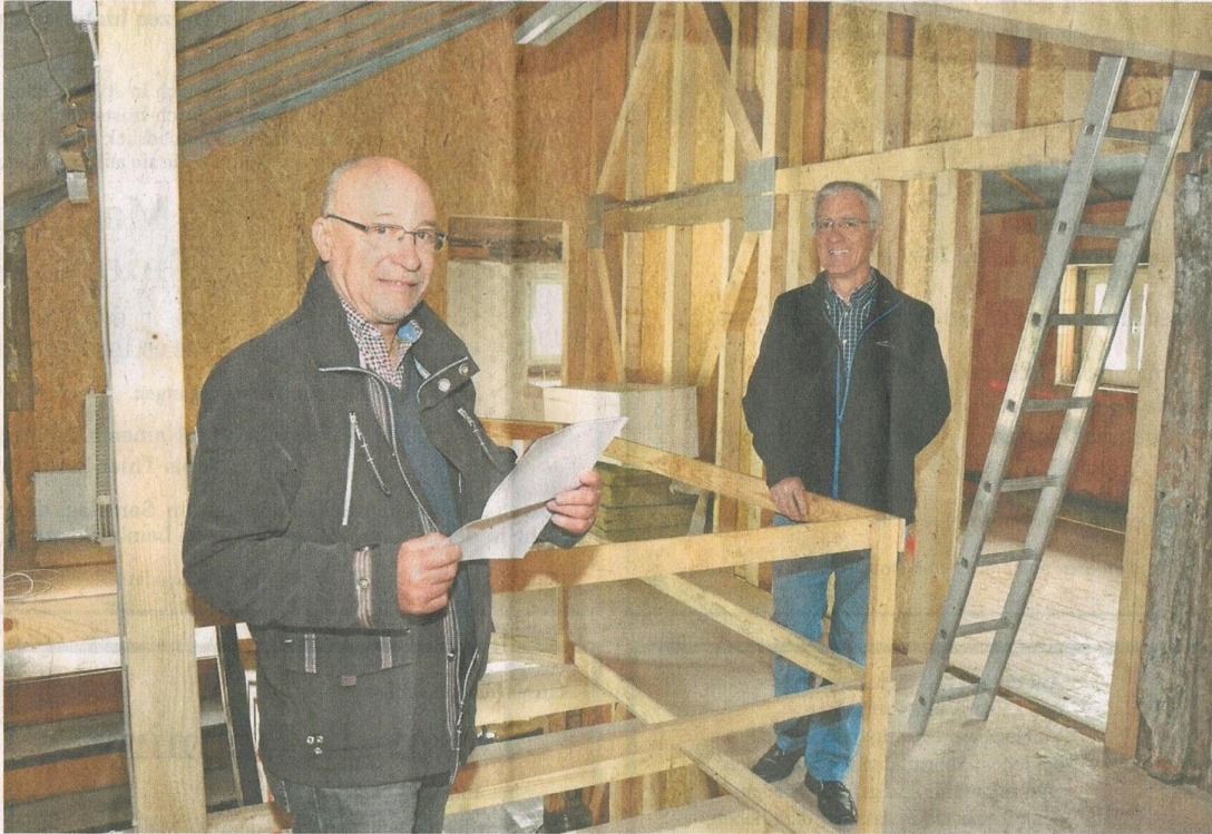
Zufrieden mit dem Baufortschritt im Heimathaus sind Heimatvereinsprecher Ferdie Schmitz und Hermann Reinbold, Vorsitzender des Bürgervereins Hof Jünger. In der oberen Etage sollen ein Besprechungsraum, ein Büro sowie ein Raum für Theaterrequisiten Platz finden. RN-FOTO FEHMER
