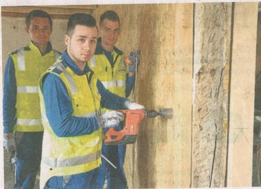
Luca Kleine-Wieskamp, Michael Zöfeld und Michael Göriz (v. l.) von der EVNG (eine ELE-Tochter) sind derzeit damit beschäftigt, Steckdosen und Kabel für die Elektrik im Heimathaus zu verlegen. RN-FOTO FEHMER
