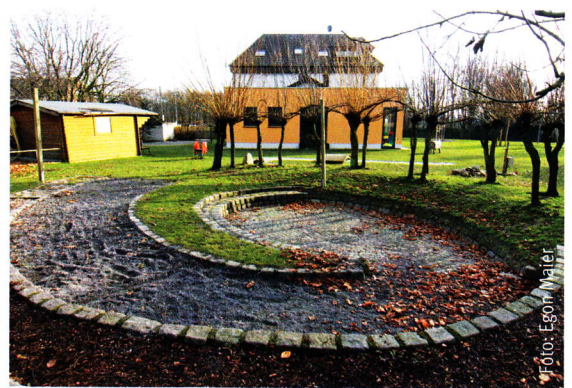
Heute fungiert das Gebäude als Kindergarten. Dafür waren einige Um- und Anbauten an dem alten Bau notwendig.
