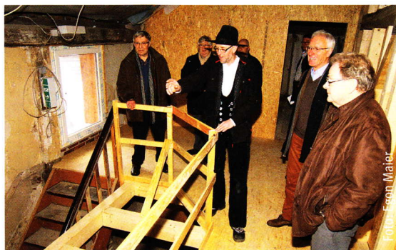
Die Renovierung des Hofes Heisterkamp schreitet dank der zahlreichen Unterstützer mit großen Schritten voran.
